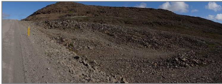
Mynd 7.5. Klappir í námu V-05, hér við veglínu A, B og C, stöð um 9500. (Mynd HBJ).
